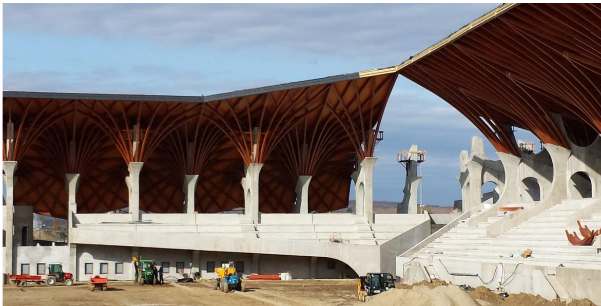
Odborná prehliadka futbalového štadióna vo výstavbe vo Felcsúte v Maďarsku
