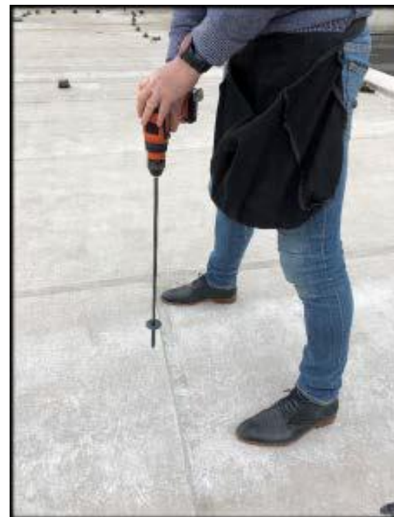
PREDLŽENIE BITU M6 x 600 s guľčkovým zaistením
