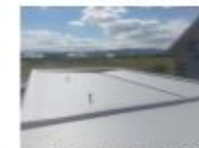
Obr. 1. 3. Plechová střecha s PVC fólií
