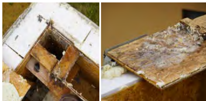
Obr. 6 Výrazná degradácia OSB dosiek a drevených hranolov zasiahla aj atiku, ktorá bola z nich vytvorená a podkladnú dosku pod oplechovanie atiky (doska je už otočená, jedná sa o jej pôvodne spodnú stranu).
