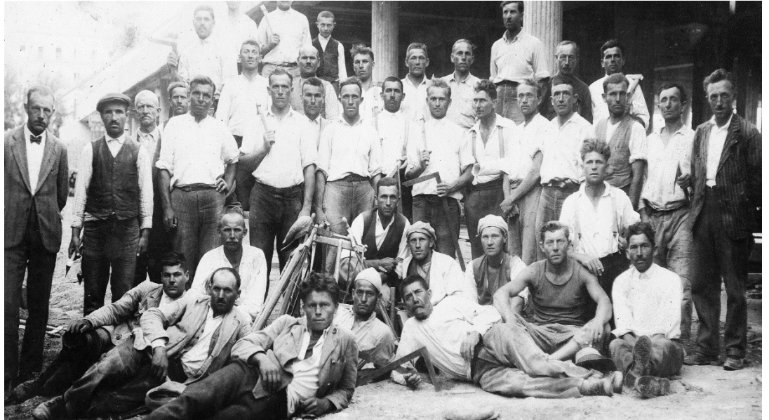
Sásovskí murári a tesári pri výstavbe liečebného domu Palace, hotelová časť na Sliaci v roku 1932. (Sásová je miestna časť Banskej Bystrice.) Foto: archív J. Kollár
